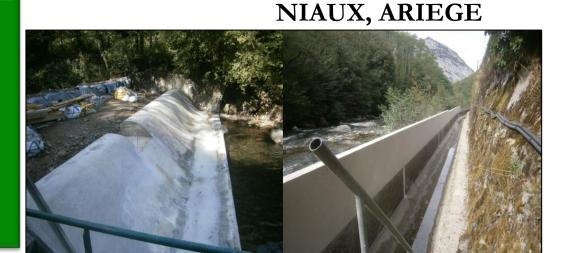
Au mois de juin 2018 la Régie Municipale d'Electricité de Tarascon-sur-Ariège a décidé d'engager un programme de travaux de maintenance à la prise d'eau de sa centrale du Sut du Teil. Les embâcles, les aléas climatiques et le temps avaient dégradé le barrage, et lors de périodes de hautes eaux le canal d'amenée se retrouvait submergé
