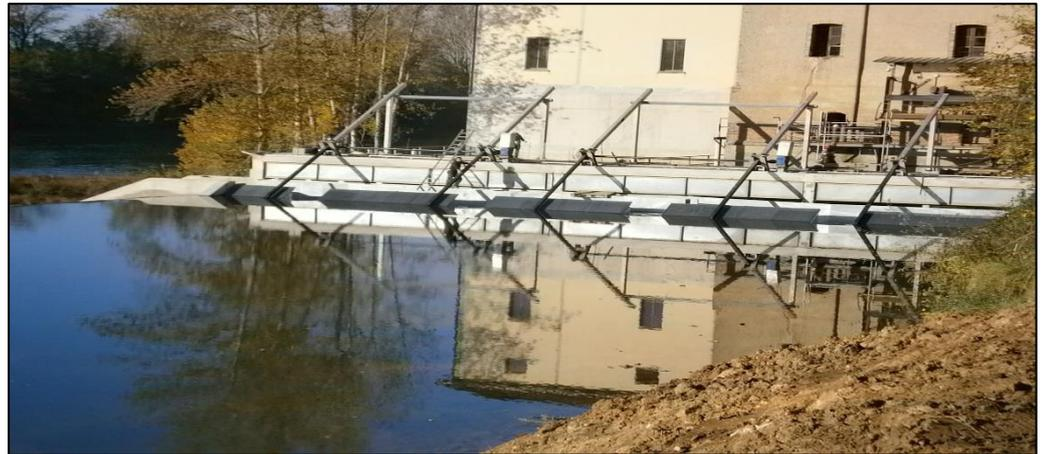
Dans le cadre d'une opération de rénovation globale de sa centrale de Corbarieu, la SA SECH a souhaité se mettre en conformité relative à la continuité piscicole en remplaçant son plan de grille actuel par un dispositif ichtyocompatible.
